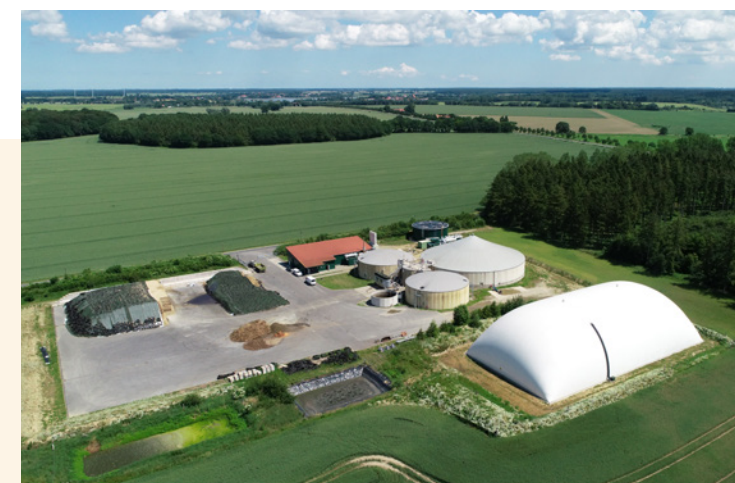
Regeneratives Speicherkraftwerk in Oebelitz, Mecklenburg-Vorpommern, das von Landwirt Moritz Raben betrieben wird.
