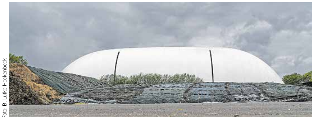
Zwei Energiespeicher auf einem Bild: Im Hintergrund ist der Gasspeicher, das „Tüttendorfer Ei“, zu sehen. Im Vordergrund liegt Silage. Sie speichert Sonnenenergie von der Ernte bis zum Einsatz in der Biogasanlage.
