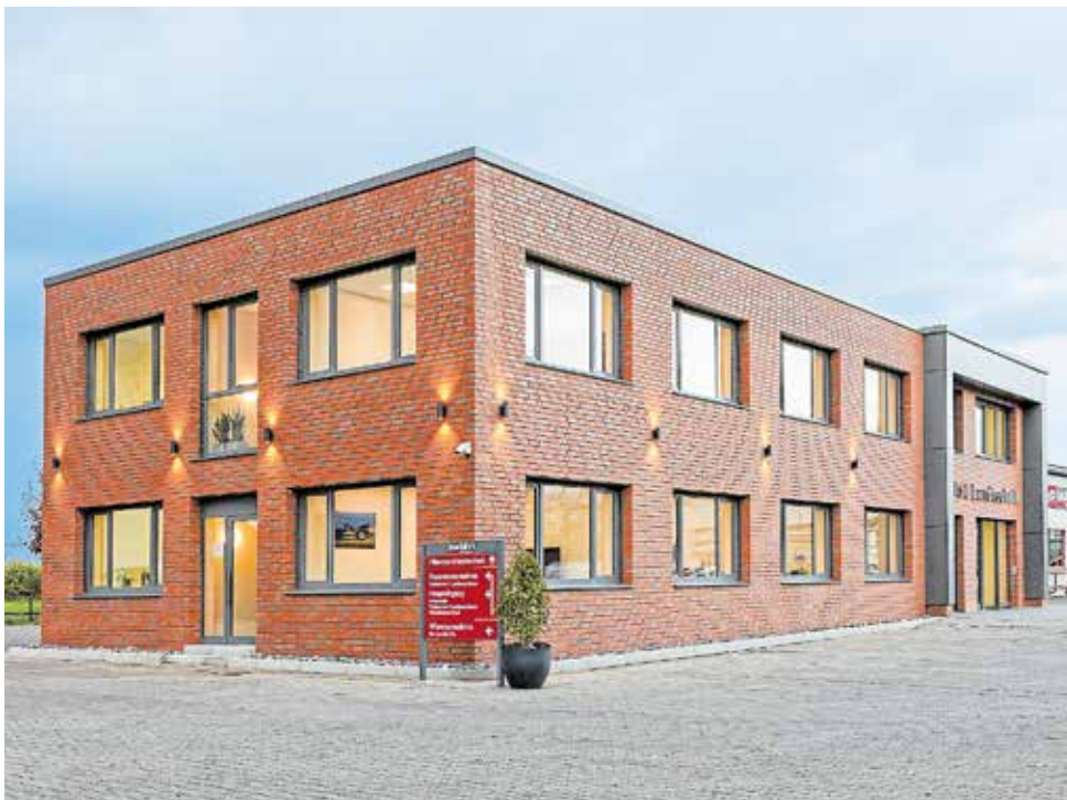
Seit 2022 bietet das neue Verwaltungsgebäude der Reise Landtechnik moderne Büroarbeitsplätze und Sozialräume.
